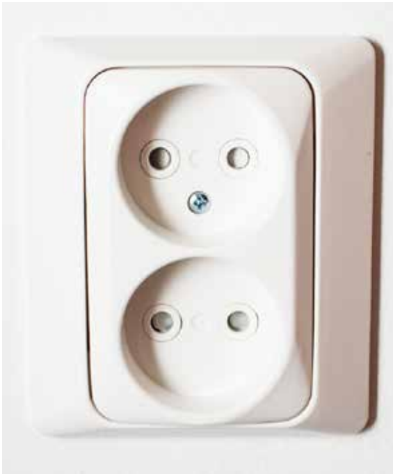
0-luokan maadoittamaton pistorasia.
