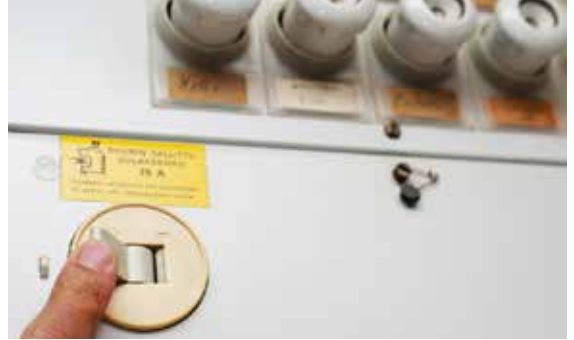
Katkaise sähkö aina ennen sähkötöihin ryhtymistä pääkytkimestä, poistamalla sulakkeet tai katkaise sähköt johdonsuojakatkaisimella. Varmista, että kukaan ei pääse vahingossa kytkemään virtaa silloin kun teet sähkötöitä.
