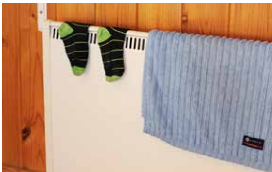
Älä kuivata vaatteita sähkölämmittimen päällä.
